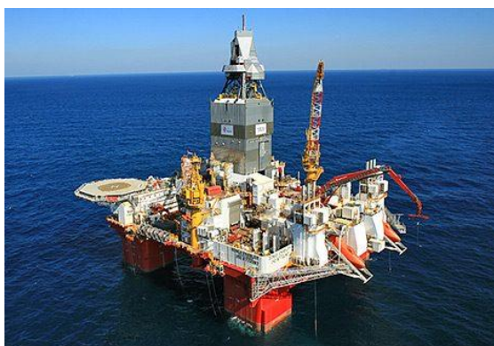
Figur 3-4 Songa Enabler som skal bore helårlig på Johan Castberg feltet
