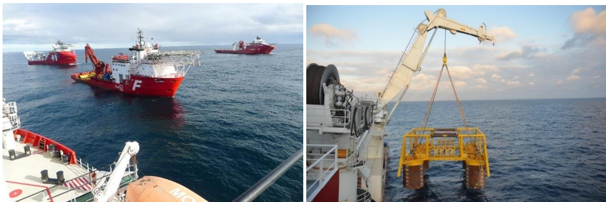
Figur 3-10 Eksempel på installasjonsfartøy og installasjon av brønnramme
