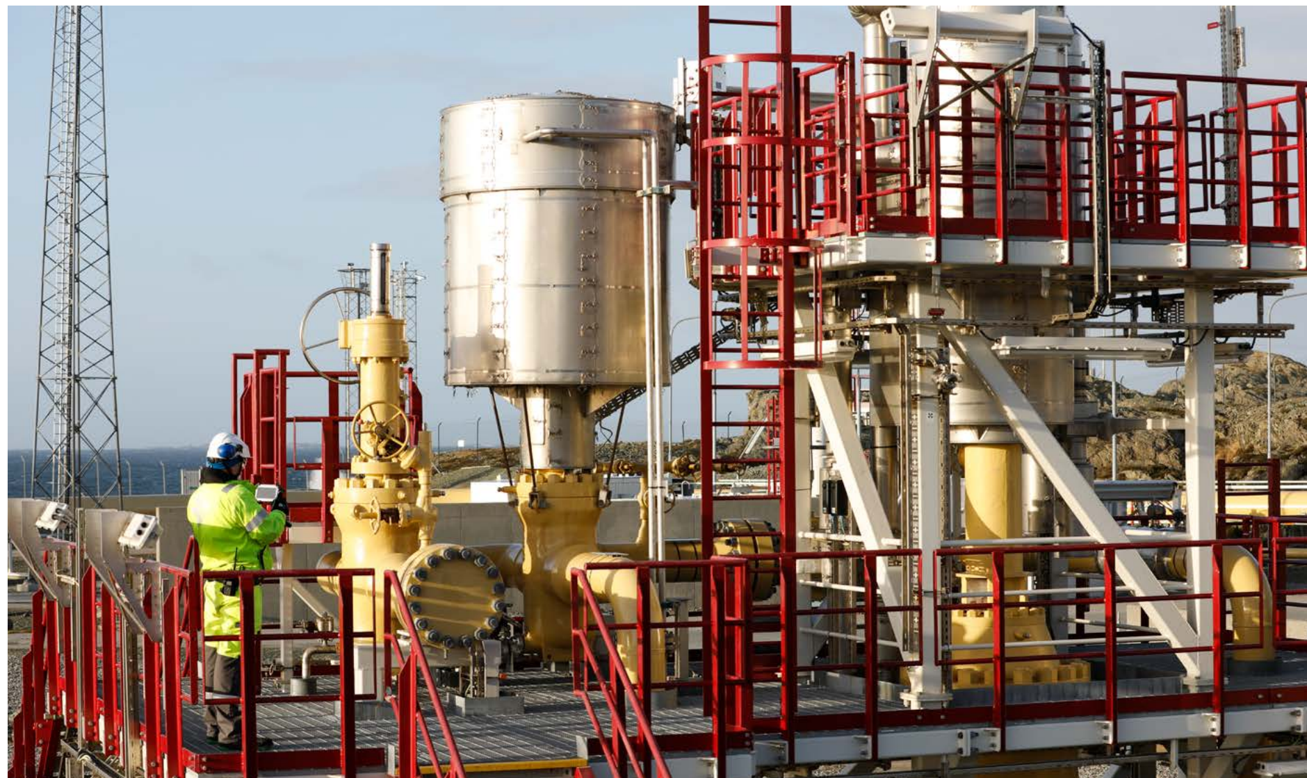
Landføringsanlegget på Kalstø, Rogaland.
