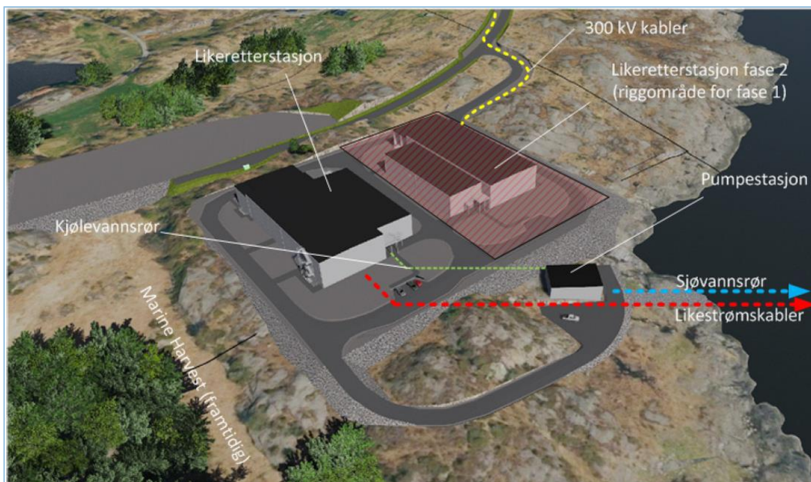
Figur 4.4. Omformeranlegget på Haugsneset ved full utbygging
