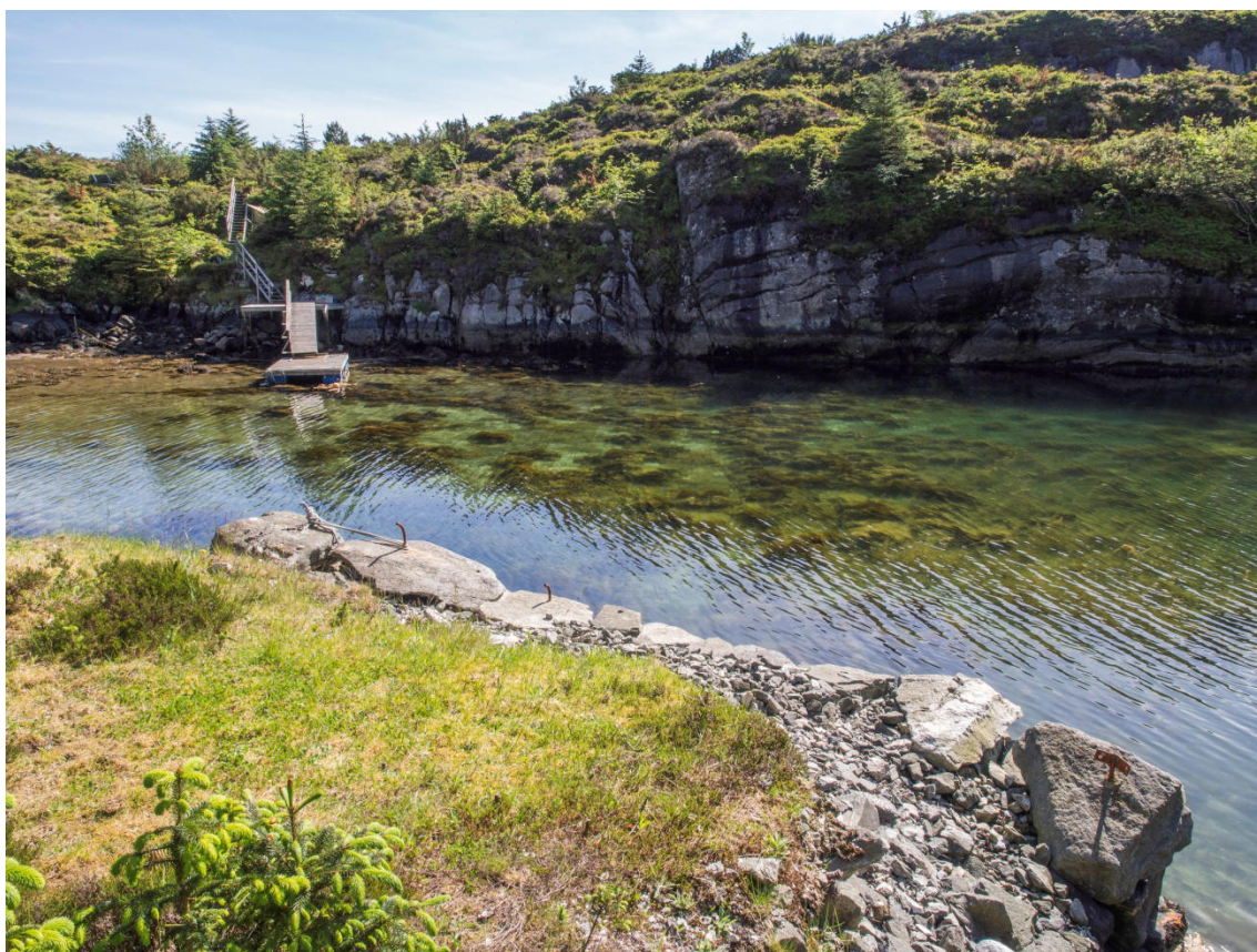
Figur 4.29. Parti fra Bergsvikhavnen med brygge og kaianlegg. Foto: Rune Idsøe.
