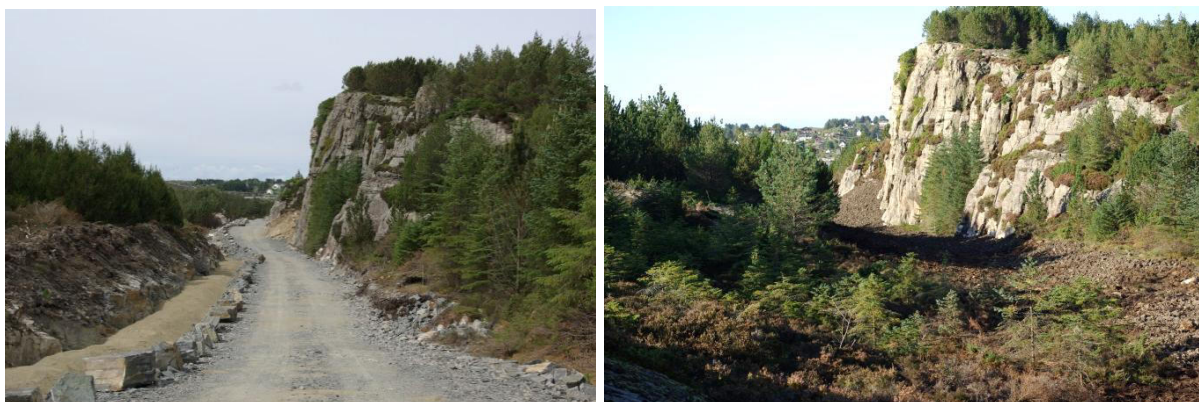
Figur 2.6. Arbeidskorridor under anleggsarbeid til venstre, der rørledning er lagt ned i grøft til venstre for anleggsveien og omfylt med sand. Avsluttet tilbakeføring av landskapet til høyre.
