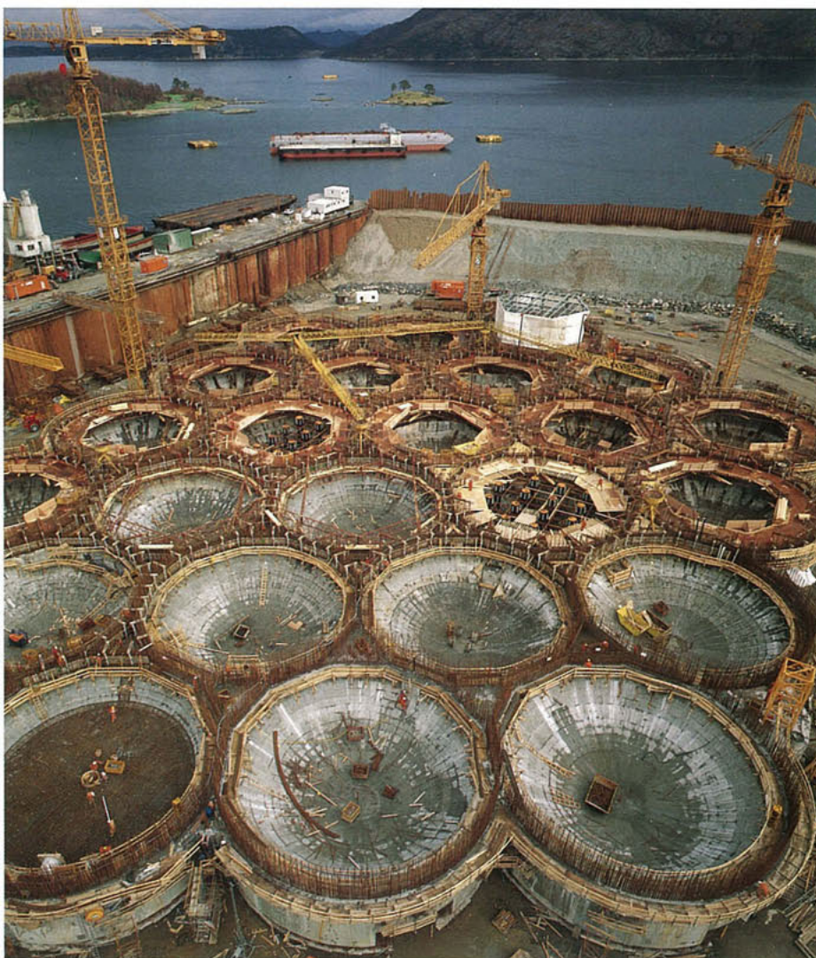
Nederst: Bunnseksjonen til Sleipner A-plattformen under bygging i Hinnavågen. Mars 1990.
