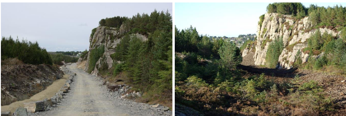
Figur 4.6. Arbeidskorridor under anleggsarbeid til venstre, der rørledning er lagt ned i grøft til venstre for anleggsveien og omfylt med sand. Avsluttet tilbakeføring av landskapet til høyre.
