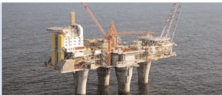
På Troll A-plattformen skal det installeres kompressorer for å transportere gassen til land etter hvert som det naturlige trykket i reservoaret synker. Statoil har valgt elektrisk drevne kompressorer. Gassdrevne kompressorer, som var alternativet, ville årlig gitt utslipp på flere hundre tusen tonn CO 2 årlig.
