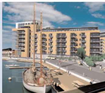
Statoil skal for første gang levere en energiløsning med varmepumper basert på sjøvann og propan til et større boligprosjekt i Stavanger.
