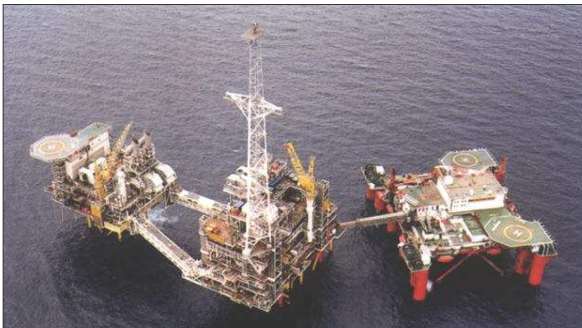
Figur 3.16. Marnock plattformen i britisk sektor. Foto hentet fra: http://www.offshore-technology.com/projects/etaps/etaps7.html
