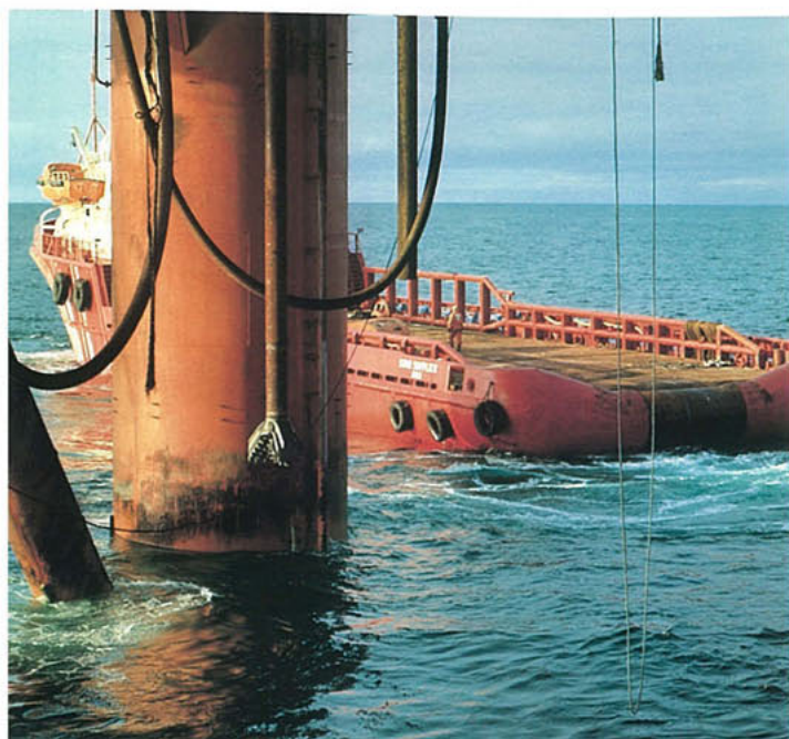
Borkronen på vei nedover mot havbunnen.
