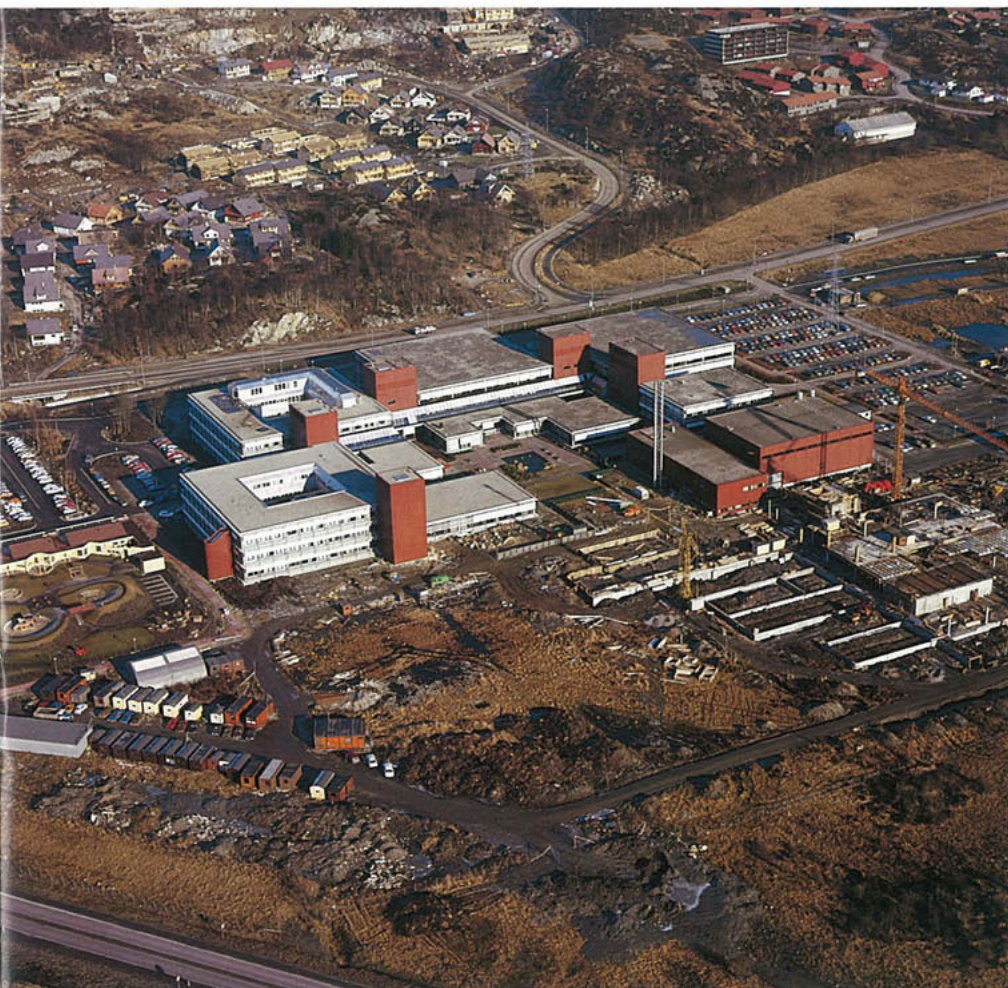
Statoils administrasjonssenter i Stavanger.
