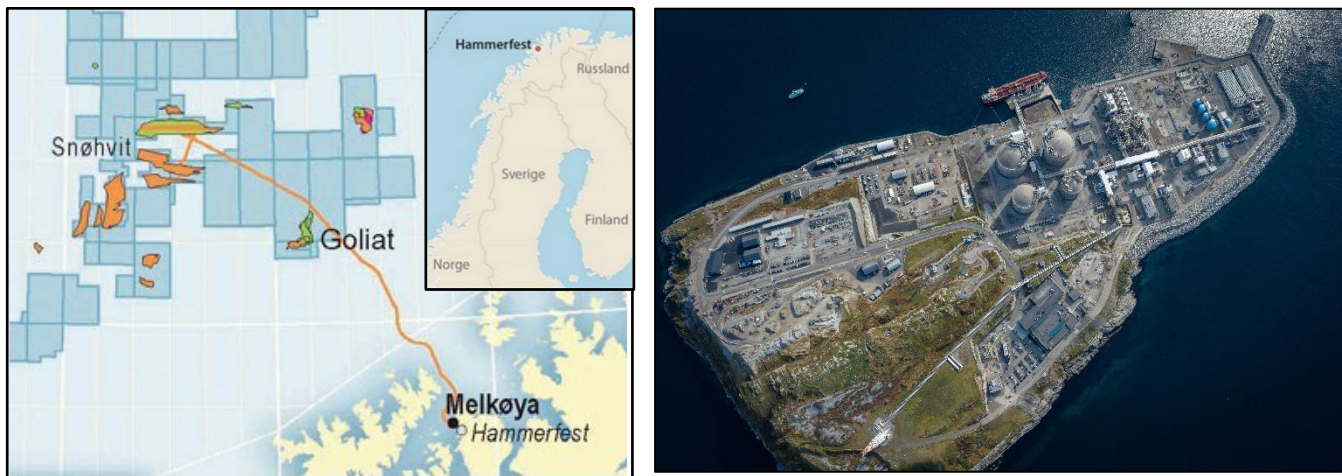
Figur 3-1 Hammerfest LNG på Melkøya (Kilde: Norsk Petroleum (v) og www.equinor.com (h))
