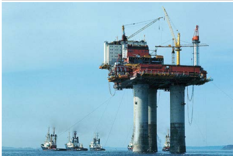
Figur 2-10 Statfjord A-plattformen med deksanlegg under uttauing i 1977
