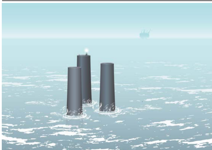
Figur 2-7 Etterlatelse av betongskaft med påmontert navigasjonslys
