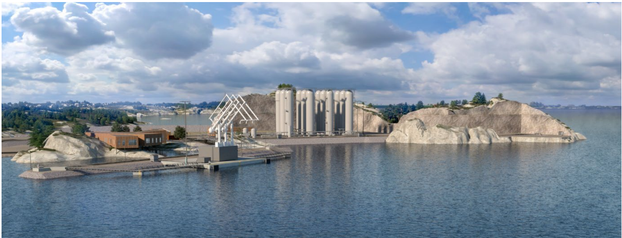
Figur 2-2 Illustrasjon av mottaksanlegget sett fra syd. Areal for en mulig framtidig utbyggingsfase 2 er vist til høyre i modellen. Fotomontasje: Rambøll.
