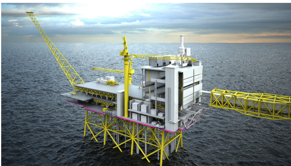
Figur 4-27 Skisse av stigerørplattformen på feltenteret
