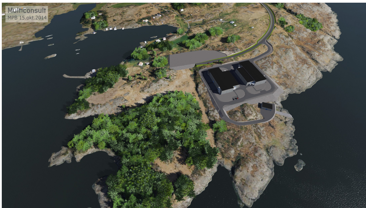
Figur 0-2 Omformerstasjon sett fra sør
