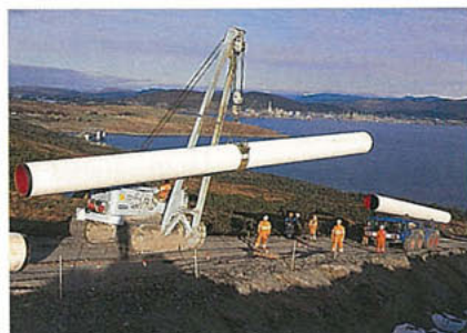
NYE STORE BYGGEGARBEIDER ER IGANG PÅ KÅRSTØ SOM EN FORBEREDELSE TIL Å TA IMOT GASS FRA ÅSGARD.
