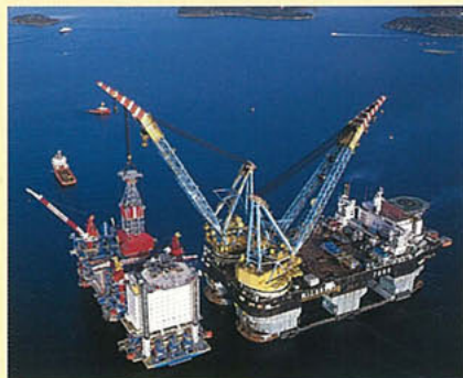
Verdens største løftartøy, italienske "Micoperi 7000", løftet moduler inn på Sleipner dekket.
