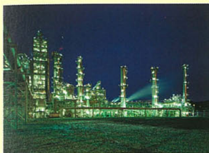
Mongstad-raffineriet har bygget propananlegg.
