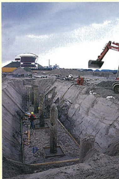
Zeepipe-terminalen i Zeebrugge (Belgia) under bygging.
