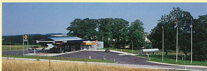
Statoil har åpnet fire nye servicestasjoner ved motorveier i Danmark.
