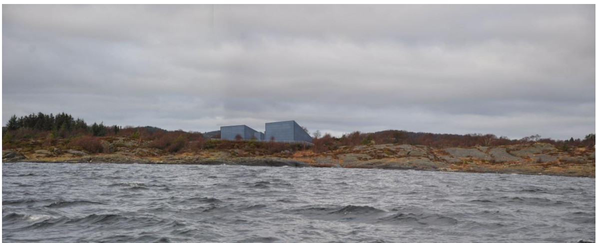
Figur 4-4 Illustrasjon 3 viser ny likeretterstasjon sett fra sjøen. Bildet er tatt fra sør mot nord og illustrer hvordan likeretterstasjonen vil se ut i strandsonen (standpunkt 4). Illustrasjon J.E.
