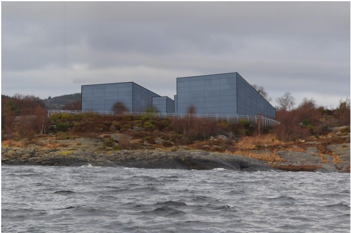
Figur 4-5 Illustrasjon 4 viser nærbilde av ny likeretterstasjon sett fra sjøen. Samme standpunkt som for Figur 4-4. Illustrasjon J.E.
