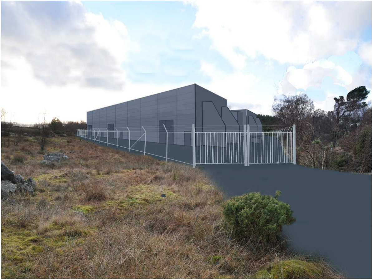
Figur 4-6 Illustrasjon 5 viser nærbilde av likerettstasjonen sett fra øst mot vest (standpunkt 3). Bygget er 12 meter høyt. Illustrasjon J.E.
