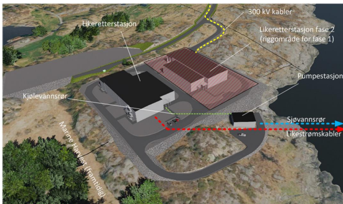
Figur 4-1 Omformerstasjon og landfall for likestrømskabler og kjølevannsledninger
