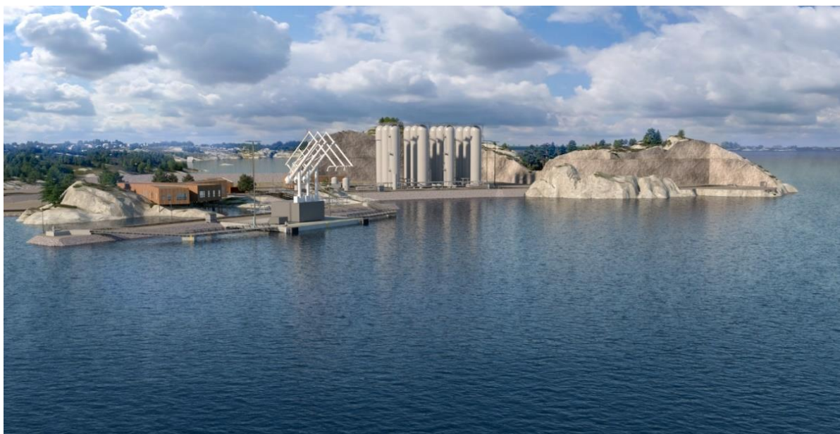
Figur 2-3 Illustrasjon av mottaksanlegget sett fra sør. Areal for en mulig framtidig utbyggingsfase 2 er vist til høyre i modellen. Illustrasjonen er basert på konseptfase, og det kan komme endringer. Fotomontasje: Rambøll.
