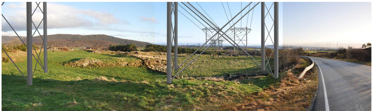
Figur 5-6 Bildemontasjen viser luftspenn alternativ A, standpunkt 1. Illustrasjonen viser utsnitt av traséen der den krysser Fv 798 og går sørøstover over kulturlandskap mot Sørhaug. Illustrasjon J.E.
