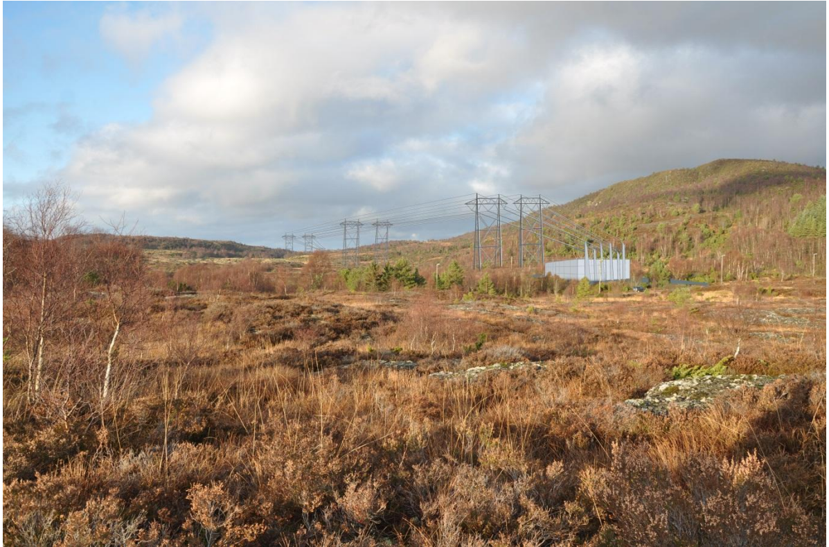
Figur 5-2 Bildemontasjen viser overgang fra nedgravd kabel til luftspenn via muffehus på Haugsnes. Standpunkt 1. Bildet er tatt fra sør mot nord. Illustrasjon J.E.
