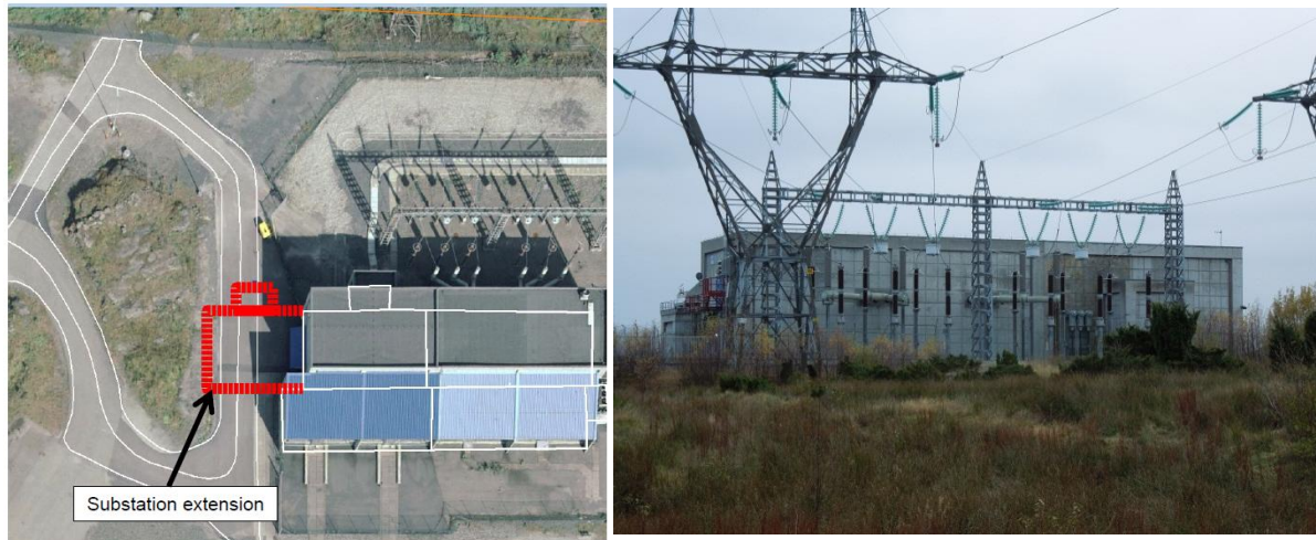
Figur 3-2 Kårstø, utvidelse koblingsanlegg (venstre /6/) dagens koblingsanlegg fra nord (høyre).
