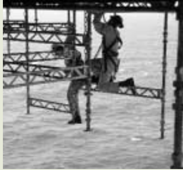
40 anlegg på land og til havs er gjennomgått i det som er blitt Statoils mest omfattende sikkerhetssjekk. Arbeidet munner ut i metoder for tilstandsmåling gjennom anleggenes levetid som skal hjelpe driftsorganisasjonene til å holde kontinuerlig god standard.
