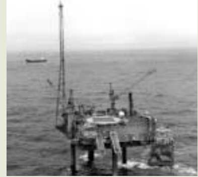
Siri er det første feltet på dansk sokkel hvor det ikke fakles gass. Dessuten blir nesten alt produsert vann injisert i reservoaret. Systemene for gjenvinning av gass og injisering av vann er etter en testperiode satt i vanlig drift i august
