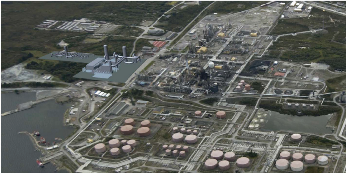
Figur 7.4. Oversiktsbilde – Mongstad anleggene med kraftvarmeverk og CO 2 fangstanlegg (Fluor / Statoil)
