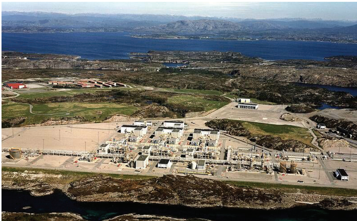
Figur 4.2. Gassbehandlingsanleggene på Kollsnes sett fra vest mot øst. Bildet er tatt år 2000 (Foto: Statoil).
