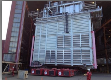
Topside module load-out
