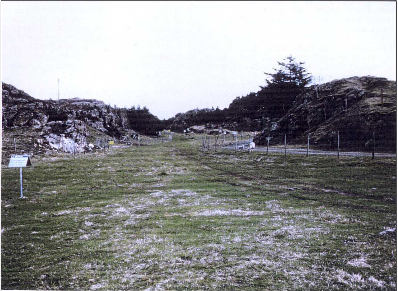
Fig 4.2 Rørledningstraséen på Karmøy, øst for Kalstø. Foto: Gunnar Henriksen.
