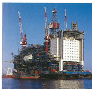
Sleipner A-dekket i venteposisjon for sammenkobling med betongunderstell og klargjøring for utslep til feltet.
