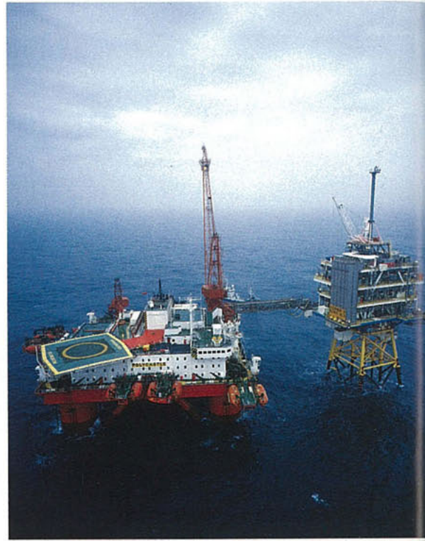
Den nye stigerrørsplattformen (til høyre) er på plass i Sleipnerområdet.
