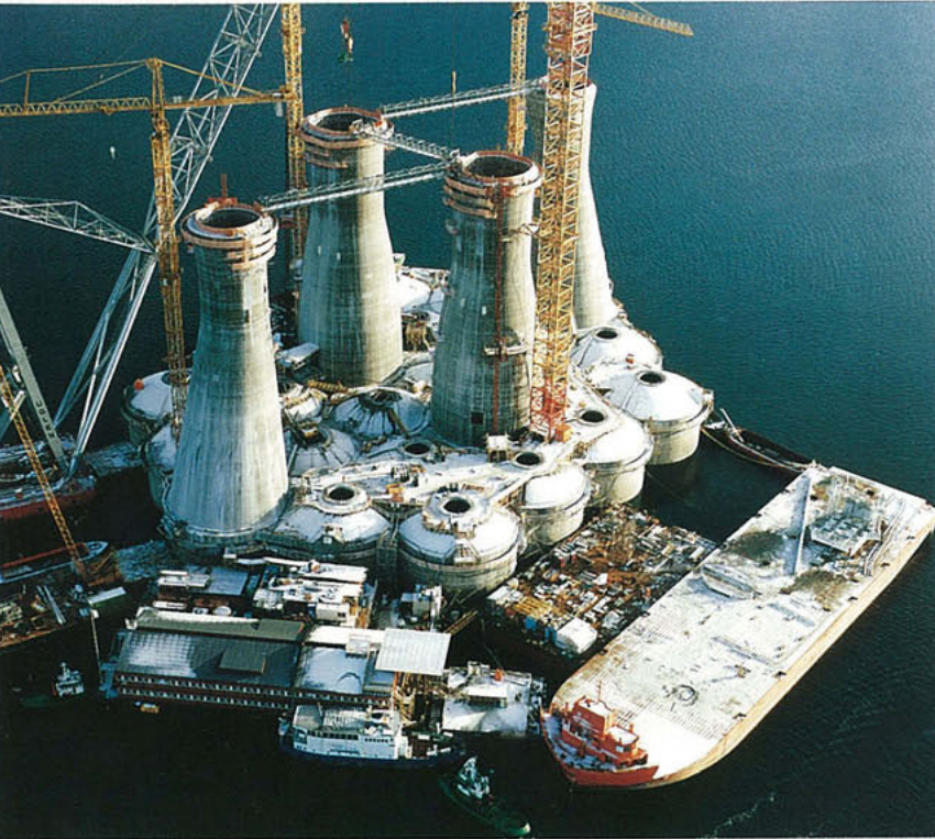
Nytt understell til Sleipner A-plattformen under bygging i Stavanger.
