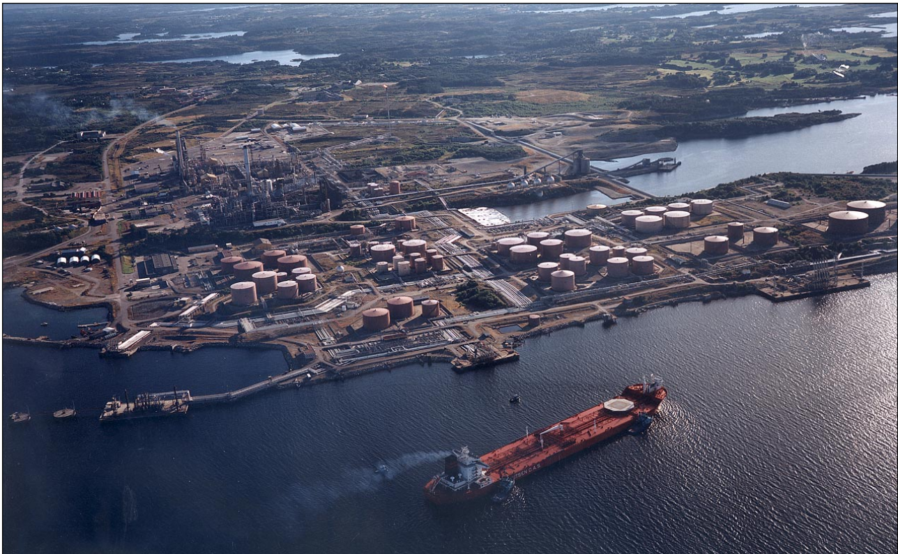
Figur 1.2. Oversiktsbilde over eksisterende raffineriområde på Mongstad.
