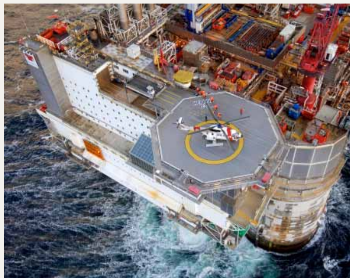
CO 2 fra gasskraftverk i Midt-Norge skal sendes til plattformene Draugen og Heidrun (bildet) der klimagassen skal brukes til å øke oljeutvinningen.
