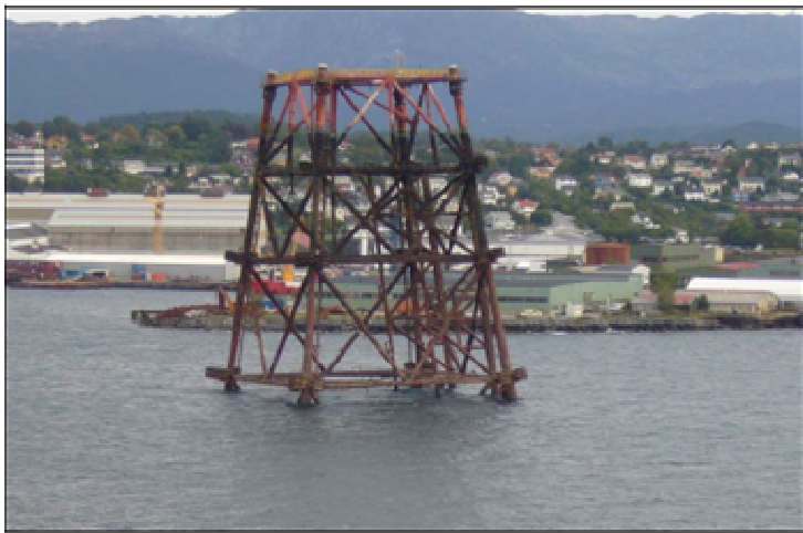
Figur 6-4. Illustrasjon av stålunderstell som mellomlagres innaskjærs før transport til opphuggingslokalitet.
