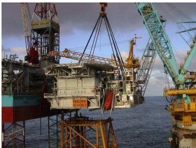
Figur 2-5. Installasjon av overbygning på Huldra ved tungløft.
