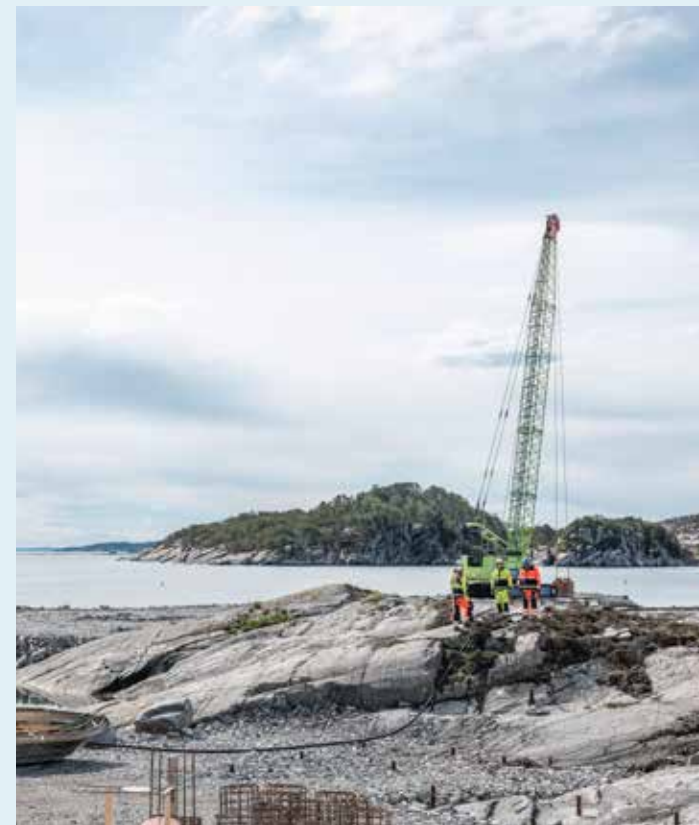
I GANG: Første spadetak for Northern Lights ble tatt i Øygarden tidlig i 2021. Foto: Ole Jørgen Bratland.
