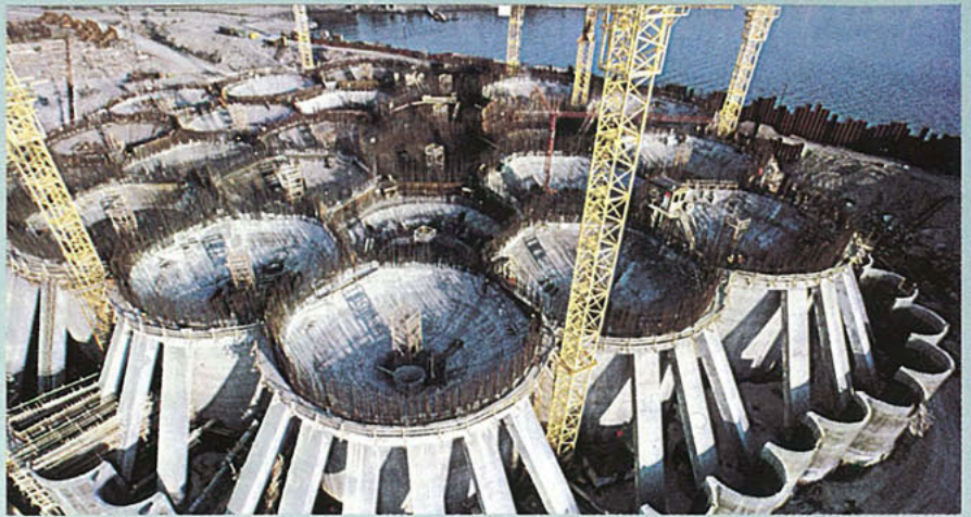
Betongdelen til Statfjord B under bygging i Hinnavågen mars 1979. B-plattformen blir verdens største produksjonsplattform for olje. Den har en grunnflate på 18 mål.
