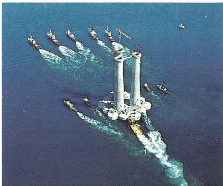
2) August 1976: Betongdelen for Statfjord A ble tauet fra Stavanger til Stord.
