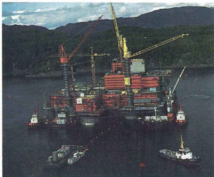
3) September 1976: Ståldekk og betongdel ble koplet sammen ved Stord Verft.
