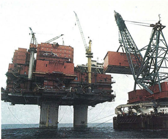
5) September 1977: Konstruksjonsarbeidet fortsatte på feltet. Moduler heises på plass av Sea Troll .
