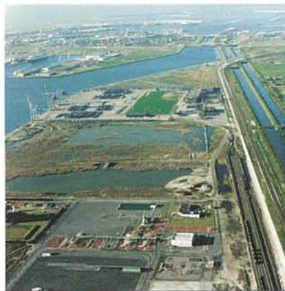
The Zeebrugge terminal.
