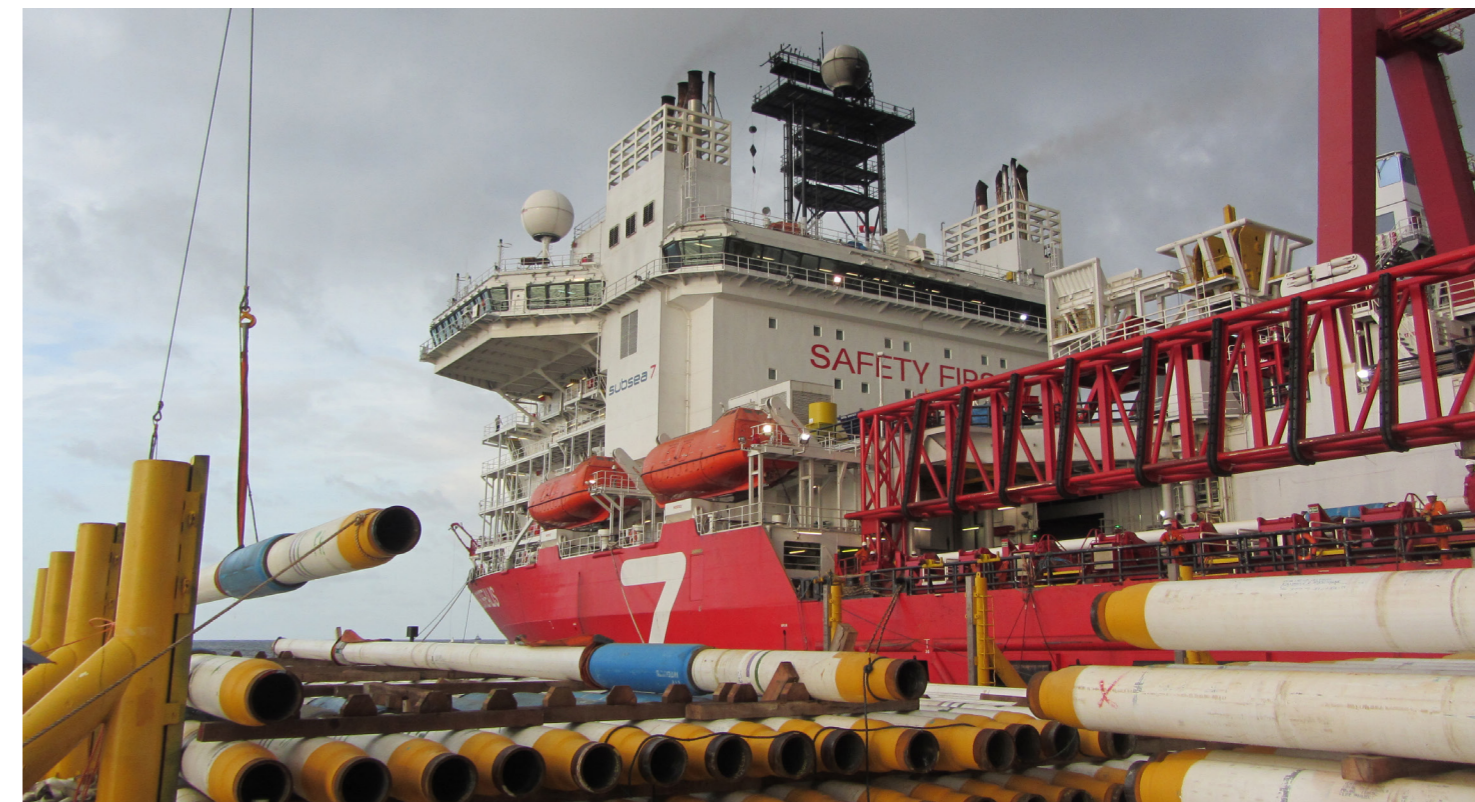
Seven Borealis installerte gassrørledningen. Foto: Subsea7
