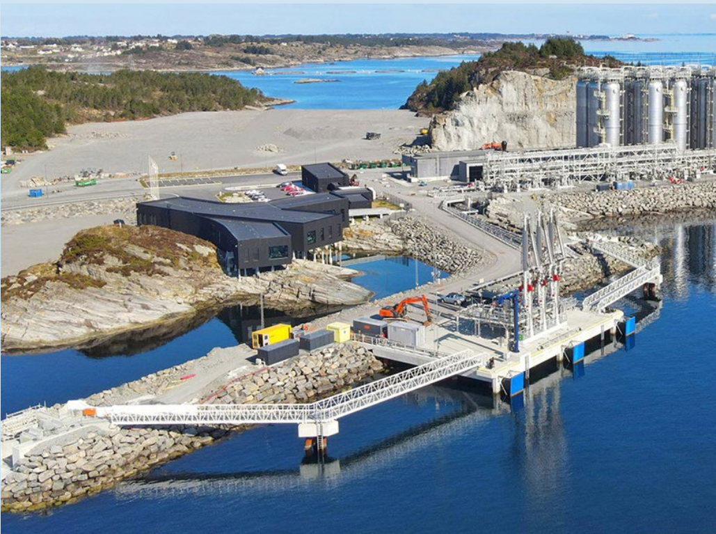
Northern Lights mottaksterminal på Øygarden utenfor Bergen.
