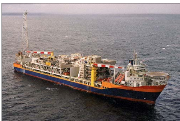
Figur 2.14. Åsgard A vil med eksisterende kraftgenererende utstyr generere og eksportere nødvendig kraft til drift av kompressorstasjonen.
