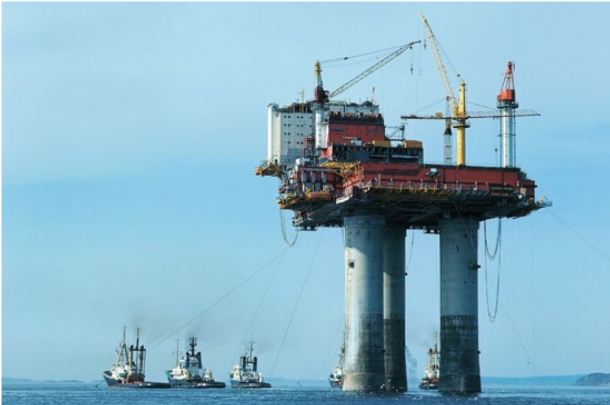
Figur 2-3 Statfjord A-plattformen med plattformdekk under uttailing i 1977
