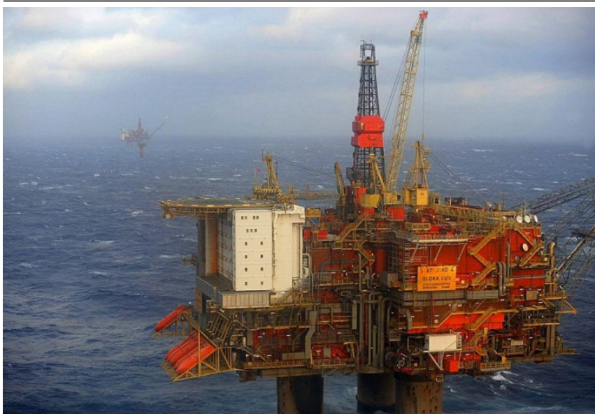
Figur 2-2 Statfjord A-plattformen, plattformdekket
