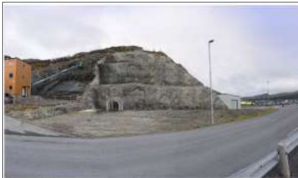
Figur 2-4 Overgang fra kabel i tunell (stiplet linje) til sjøkabel (heltrukken linje) ved Meland. Planlagt skjæring 30 meter lagt i terrasser i fjellknausen. Stigen er vist som brunt område til høyre for Rossmollgata) Fotomontasje: terrenget før og etter ved tunellpåhugget i fjellknausen Stigen. Kilde: Multiconsult 2020/Equinor.
