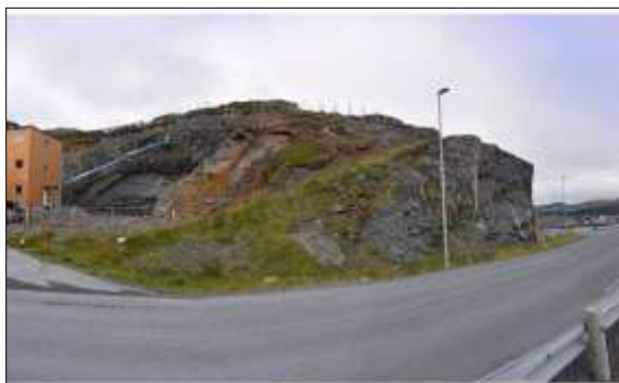
Figur 2-4 Overgang fra kabel i tunell (stiplet linje) til sjøkabel (heltrukken linje) ved Meland. Planlagt skjæring 30 meter lagt i terrasser i fjellknausen. Stigen er vist som brunt område til høyre for Rossmollgata) Fotomontasje: terrenget før og etter ved tunellpåhugget i fjellknausen Stigen. Kilde: Multiconsult 2020/Equinor.
