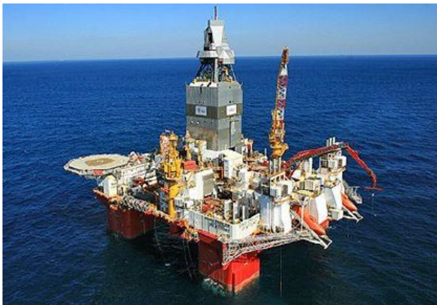
Figur 3-2 Eksempel på borerigg som kan bli benyttet av Krafla-prosjektet.
