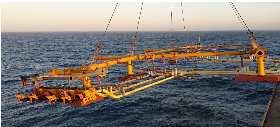
Figur 3-16 Installasjon av sammenkoblingsrør (spools).
