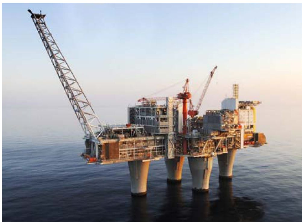
Figur 5.1 – Troll A plattformen
