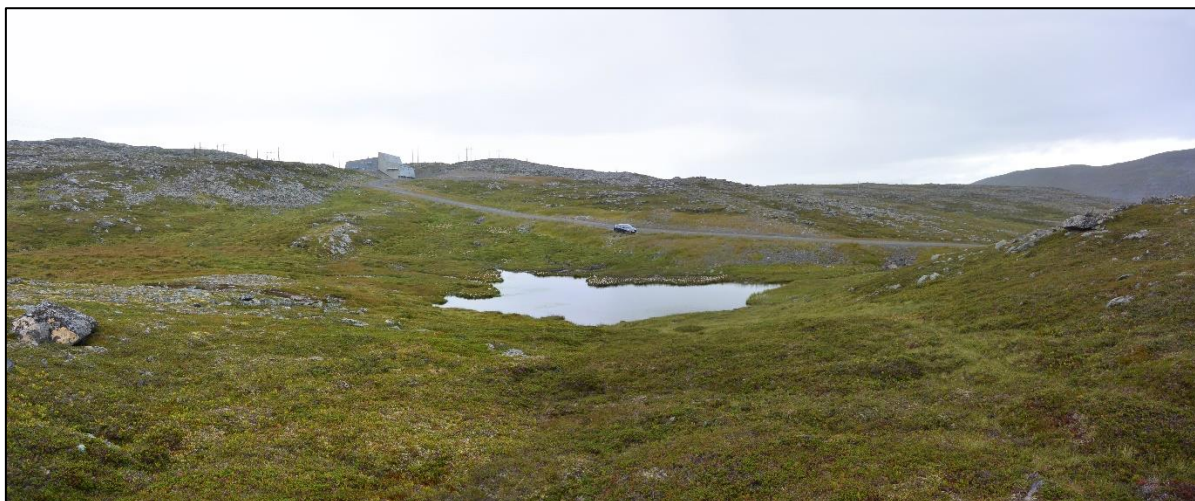
Figur 9-2. Området rundt eksisterende transformatorstasjon ved Hyggevaan.
