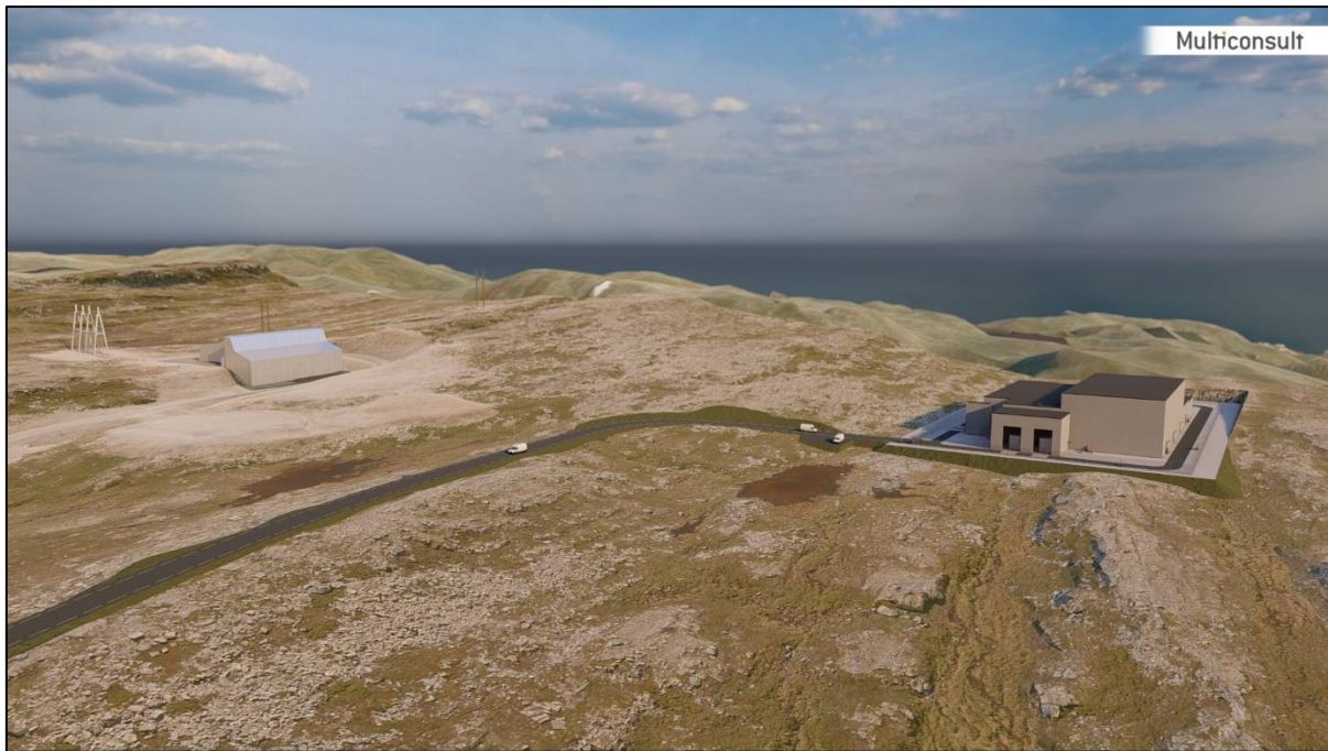
Figur 9-8. HVDC-stasjonen (til høyre i bildet) med eksisterende Hyggevatn transformatorstasjon (til venstre i bildet) sett fra nord.
