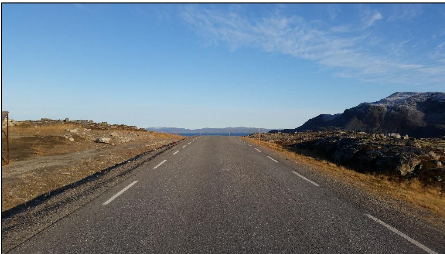
Figur 2-10. Forsølveien (fv. 8124) sett i retning Forsøl. Kabel til Kvalfjorden planlegges lagt på venstre side av veien.
