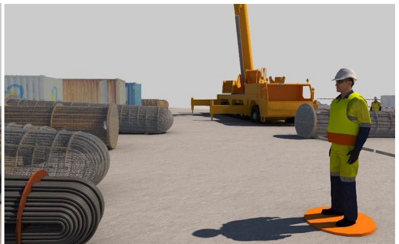
Figur: Plassering av signalgiver i forhold til kranfører. De var plassert ca. 20 meter fra hverandre
