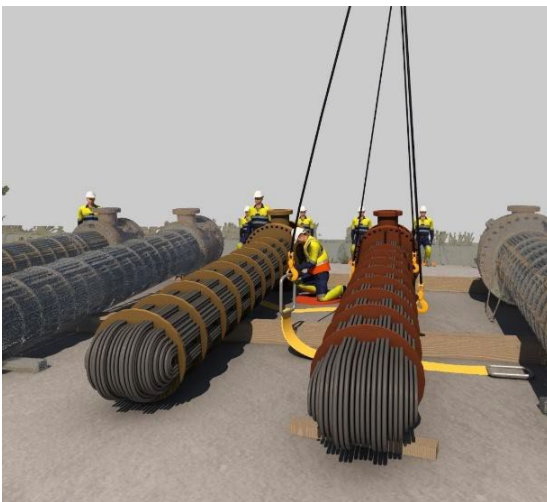
Figur: Situasjonsbilde sett fra signalgivers posisjon. Anhuker skjøv flatstropp under neste varmeveksler som skulle løftes for inspeksjon.
