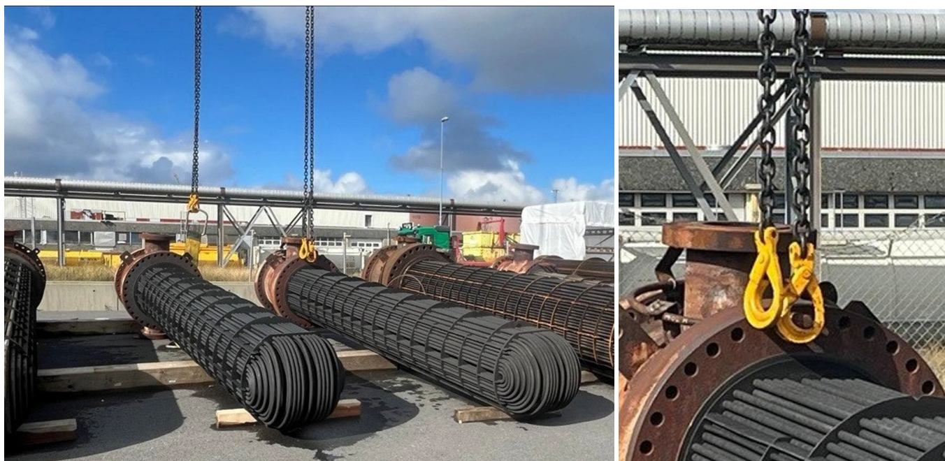
Figur 6-1 Krok fra kjettingskrev hektet seg i utstikkende bolt på varmevekslerens ledekanal
