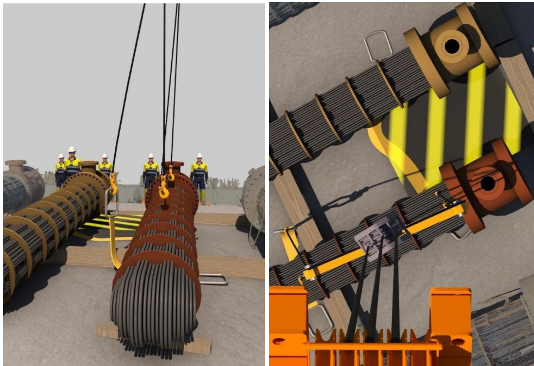
Figur: Varmeveksler ble satt ned på bakken
