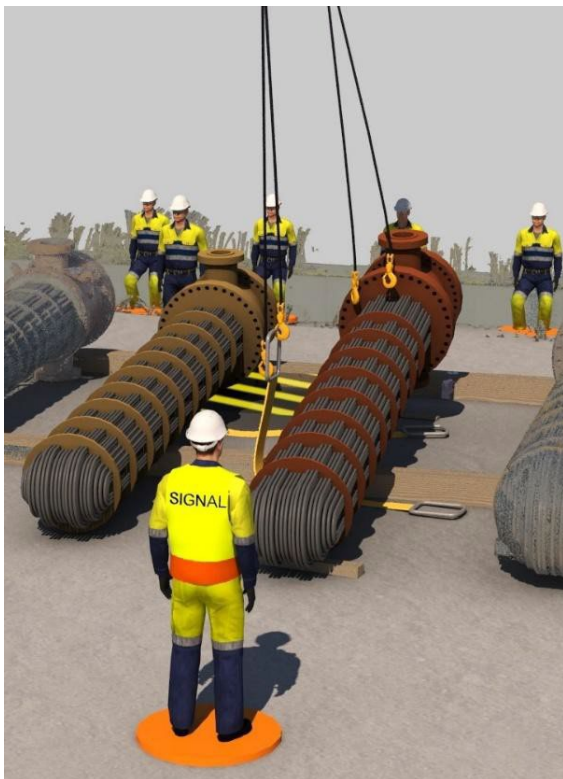
Figur: Varmeveksler løftet seg og slo mot tilstøtende varmeveksler
