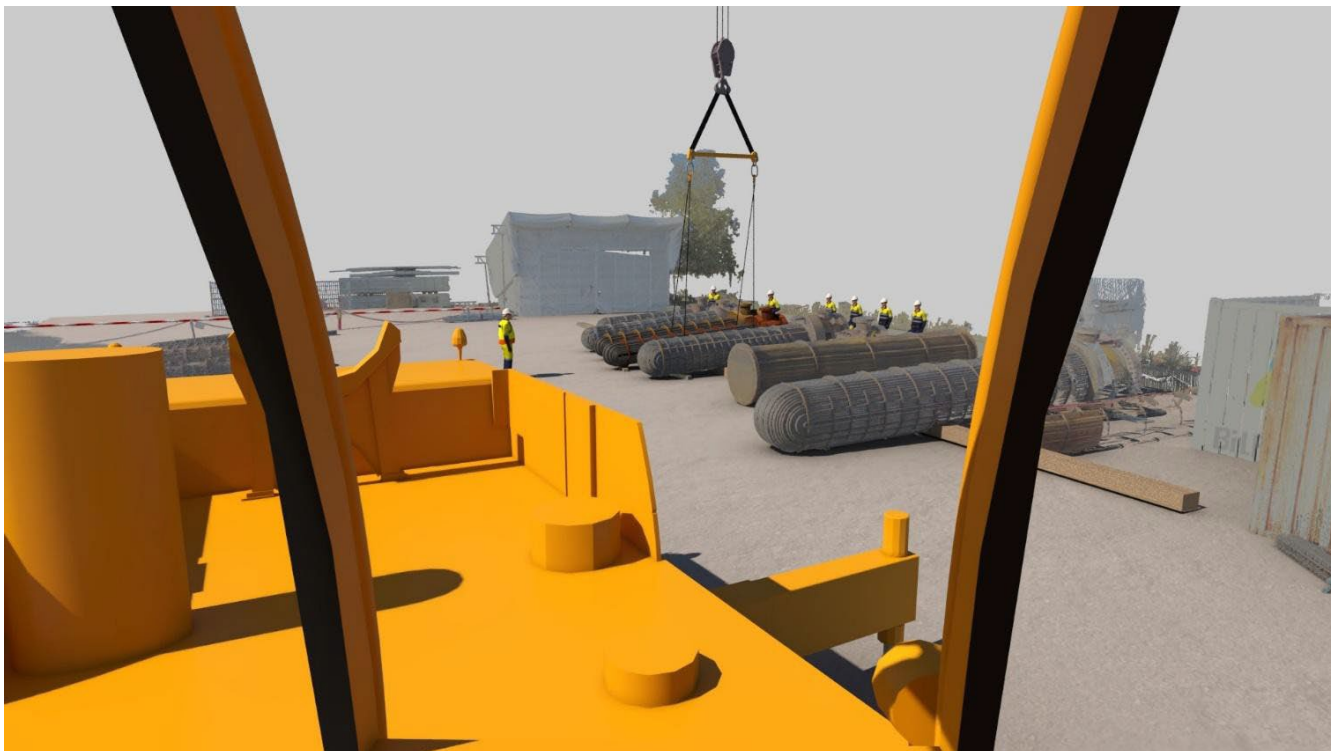
Figur: Sikt fra kranførers posisjon
