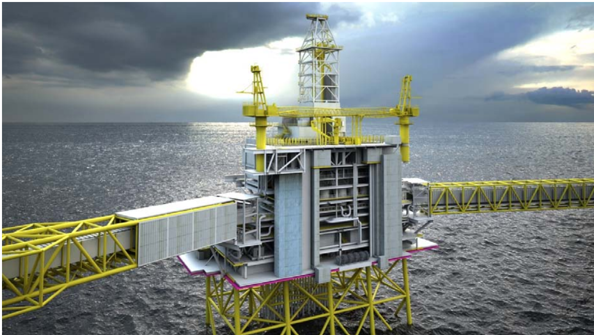
Figur 3-13 Boreplattformen med broforbindelse til hhv stigerørsplattform og prosessplattform
