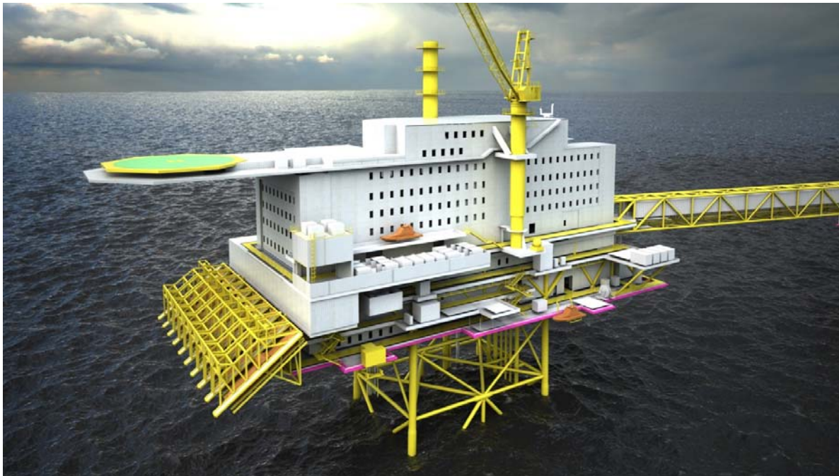
Figur 3-14 Boligplattform (LQ) med broforbindelse til prosessplattform
