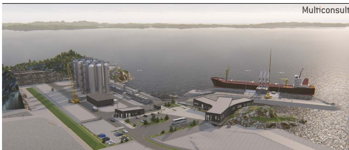
Figur 3-9 Illustrasjon av mottaksanlegg med administrasjonsbygg med besøksareal til høyre, lagerbygg ved parkeringsplassen og deler av tankanlegg med nettstasjon til venstre. Sett mot sørøst. Illustrasjon: Multiconsult.
