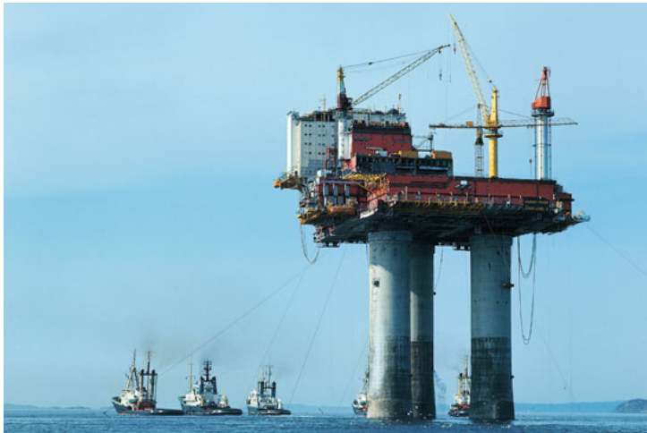
Figur 6. Fra uttauing av Statfjord A.
